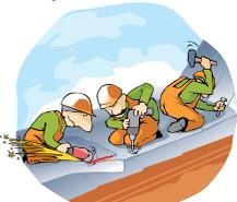
Во время монтажа металлочерепица будет неоднократно повреждена. А после использования болгарки, высокая температура разрушит защитное покрытие в местах прореза.
